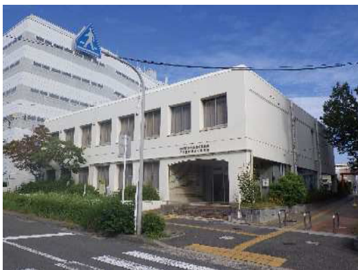
現公民館南東より
