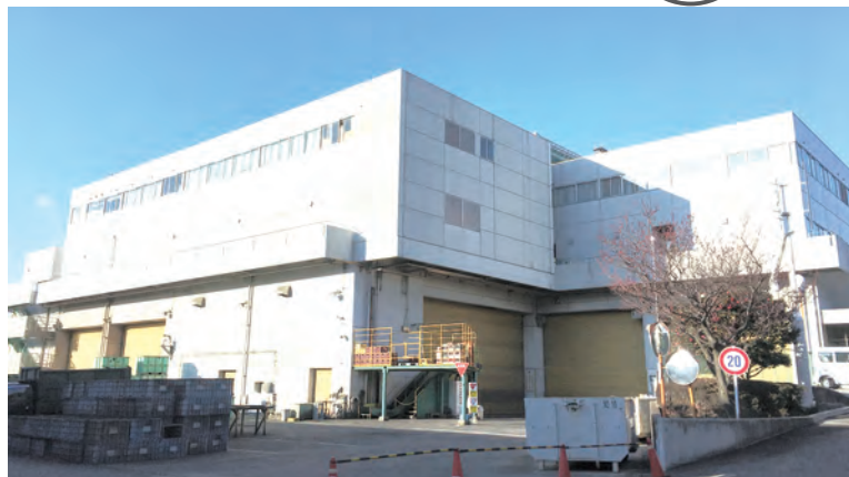
破碎選別工場
