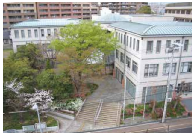
現在の吹田保健所（出口町）
