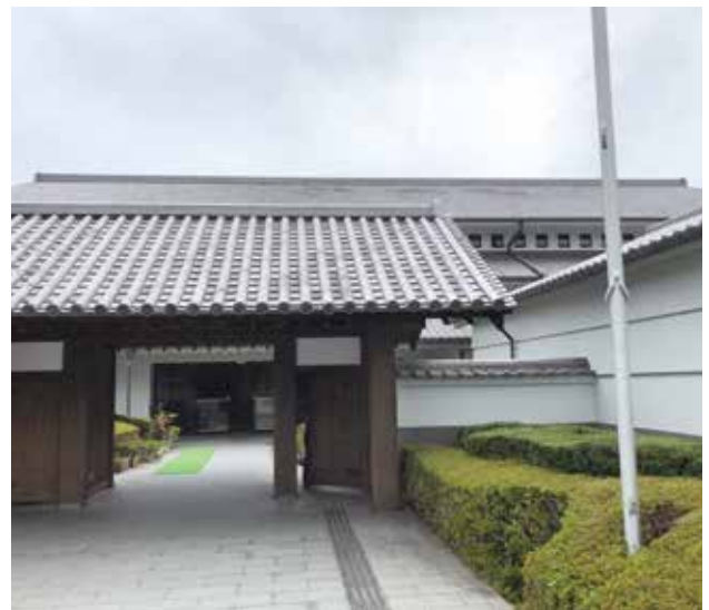
修繕予定の武道館
