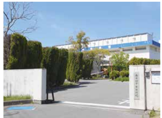
南吹田下水処理場
