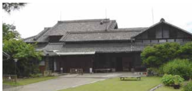
大規模修繕される旧西尾家住宅
