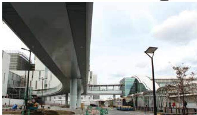
整備が進むJR岸辺駅北公共通路
