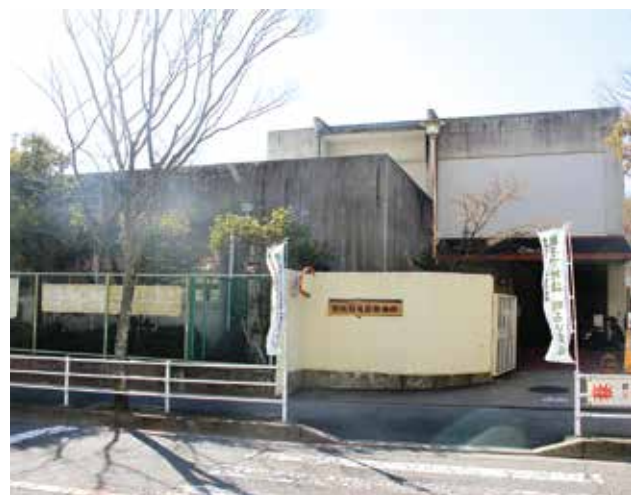
防災備蓄倉庫として改修される旧西山田地区集会所
