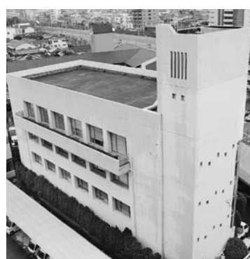
耐震診断が未実施の職員会館
