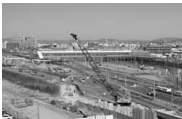
建設工事が進む東部拠点
