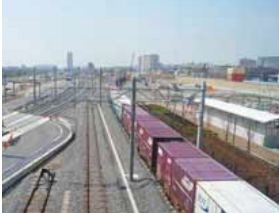
整備中の貨物ターミナルとまちづくり用地
