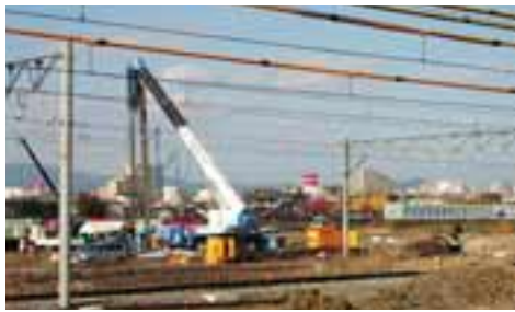
基盤整備の工事が進む東部拠点
