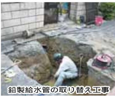
鉛製給水管の取り替え工事
