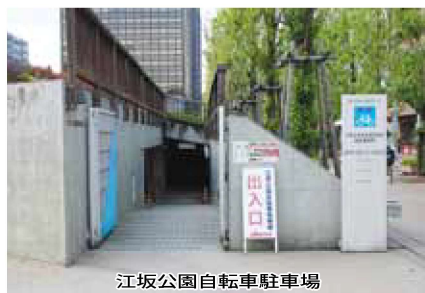
江坂公園自転車駐車場
