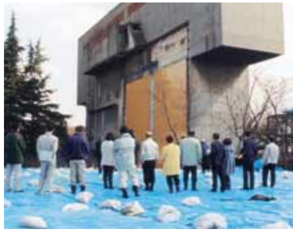
南工場跡地のダイオキシン類対策の現地視察
