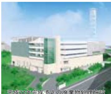
平成22年度完成予定の廃棄物処理施設
