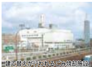
建て替えが行われるごみ焼却施設
