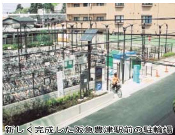
新しくて完成した阪急豊津駅前の駐輪場
