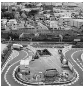
立体交差工事の様子
