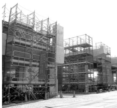
南吹田における新駅建設工事
