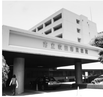
移転建て替え予定の現市民病院
