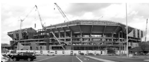
建設が進む（仮称）吹田市立スタジアム
