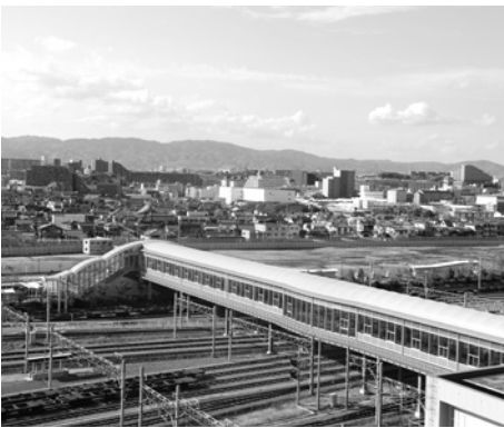
岸辺駅前の吹田操車場跡地
