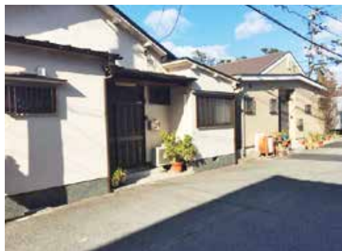
昭和23年(1948年)建築の江坂住宅
