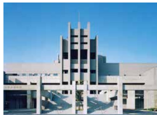
改修工事が実施される博物館
