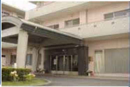
施設外観（3階建て）
