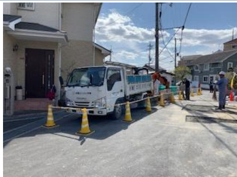
工事現場風景(一例)
