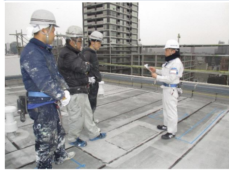
現場管理の様子
