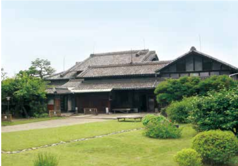
重要文化財 旧西尾家住宅
