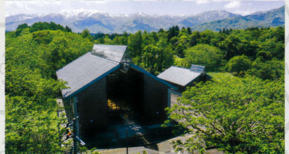
新井総合公園体育館
