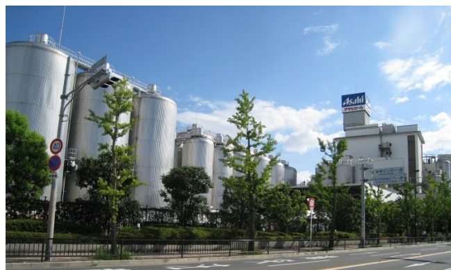
アサヒビール吹田工場（西の庄町）
