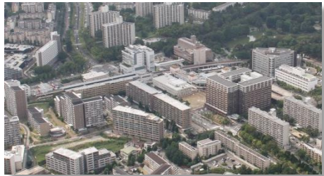
南千里駅周辺（千里南地区センター）
