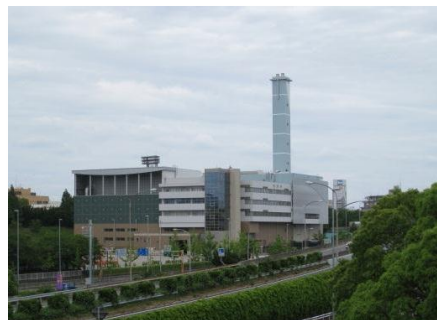
資源循環エネルギーセンター（千里万博公園）
