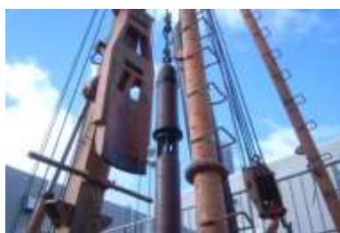
複数水源としての井戸の掘削工事
