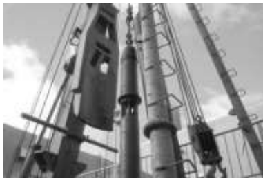
複数水源としての井戸の掘削工事
