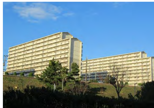
建替えられた府営住宅
