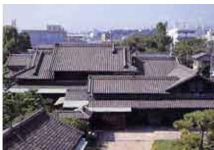
旧西尾家住宅（吹田文化創造交流館）
