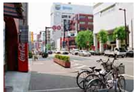
無電柱化された大阪内環状線（国道479号）
