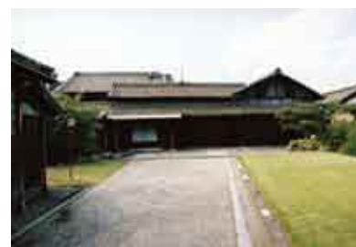
旧西尾家住宅(吹田文化創造交流館)
