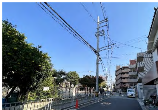
公園と隣接した集合住宅
