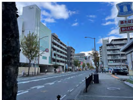
大阪内環状線（国道479号）
