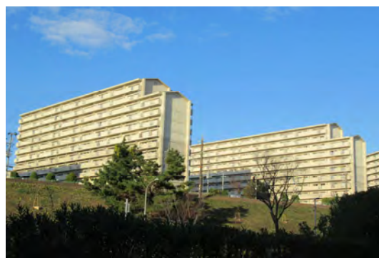
建替えられた府営住宅
