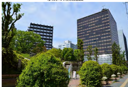
江坂公園と隣接するオフィスビル群
