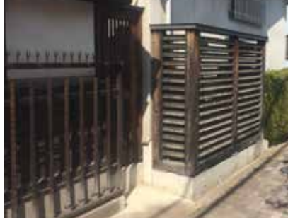
設備を木製の囲いで覆っています。 (内本町内)
