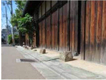
石材を使った敷際（南高浜町）
