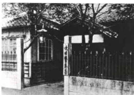
吹田警察署(明治初期の写真) 高浜町・亀岡街道沿い
