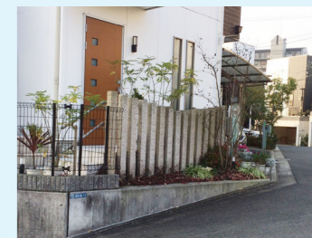
石材を使った敷際（吹田市内）
