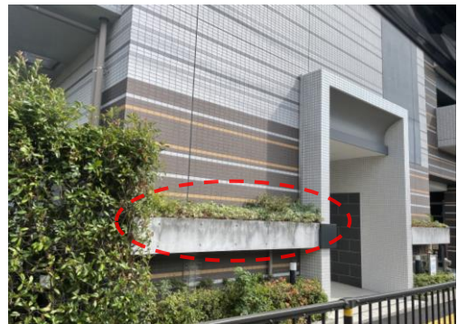
外壁と一体となったフラワーポットを設置し植栽を工夫している例
