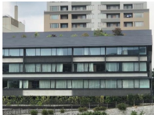
光沢のない濃い灰色を用いている例
