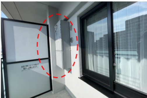
壁面に取り付く設備を外壁と同色で合わせている例
