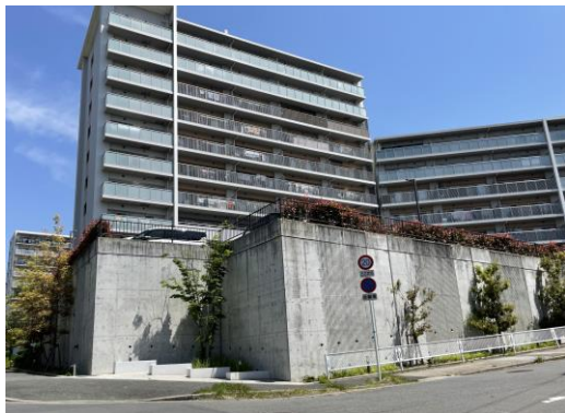
擁壁を一部セットバックさせ、縦目地の化粧型枠を用い、圧迫感を低減している例
