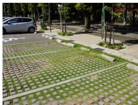
緑化ブロックで舗装し、環境面にも配慮している例
