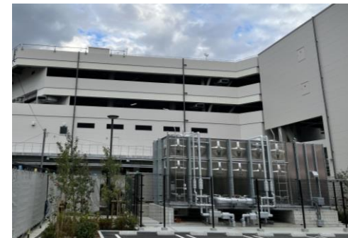
受水槽を道路などの公共空間から見えにくい配置にしている例
