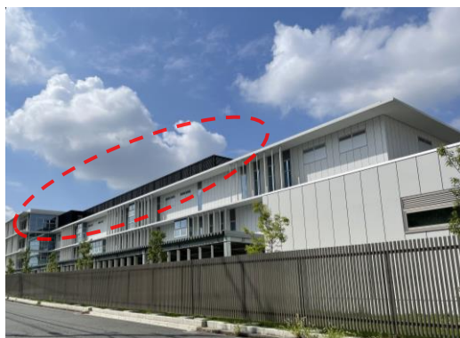
屋上設備が道路等の公共空間から見えないようにルーバーで隠している例
