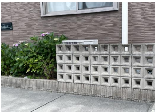
室外機をブロックで見えにくくしている例
