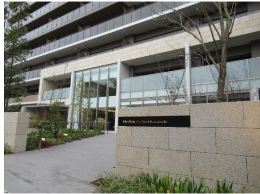
建物と同じ素材で、高すぎない塀を設置している例
