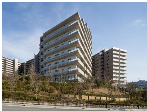
法面はなるべく緩やかな勾配とし、緑化している例
