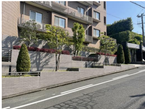
擁壁の意匠を工夫し、緑化を施すことで圧迫感を低減している例
