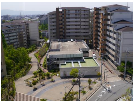
敷地の奥に立体駐車場を配置し、圧迫感を低減している例
