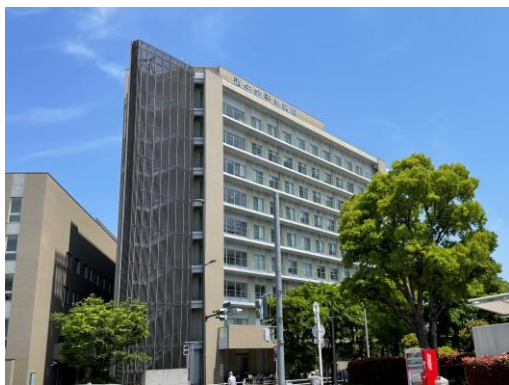
屋外階段を外壁と同系色のルーバーで囲い目立たなくしている例
