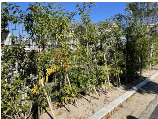
敷際の植栽を引き立てるよう、低彩度のフェンスを設置している例
