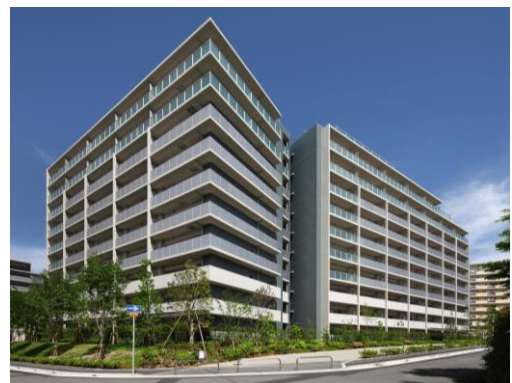
道路境界より壁面をセットバックさせ、壁面を分割し、圧迫感を低減している例
