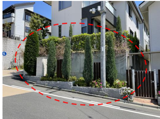
擁壁の位置を少し道路から後退させて植栽を設けている例
