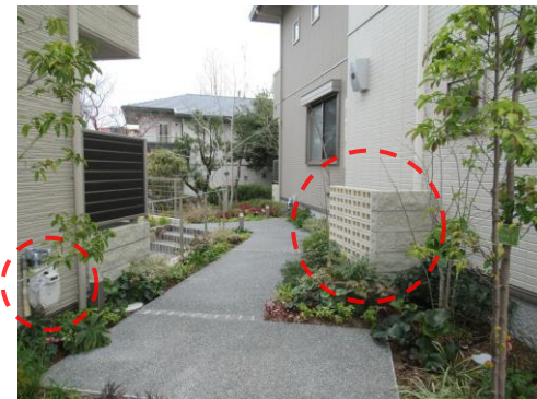
付帯設備を見えにくい位置に配置しつつ、ブロックで隠し手前に植栽を設けるなど、工夫をしている例
