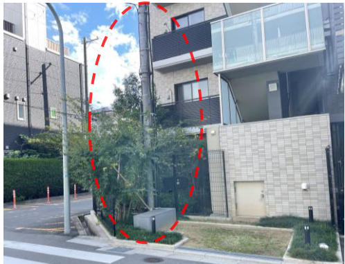
敷際に設置する引き込み柱の周りを緑化し、目立たなくしている例
