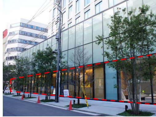
低層部だけファサードのデザインを切り替え、アイレベルのにぎわいを演出している例
