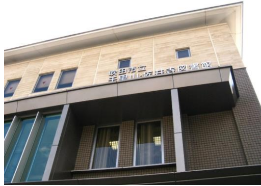
黄漆喰風の外壁にしている例
