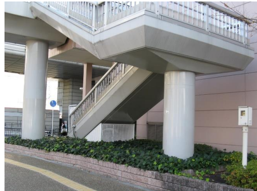
汚れの付きにくいホーロー素材を用いている例
