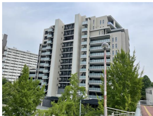
エレベーター棟を外壁と同じデザインでそろえ、建物と一体性を持たせている例
