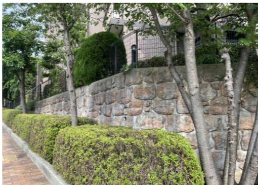
自然石風の化粧型枠を使用した擁壁と、前面に植栽を配置した例
