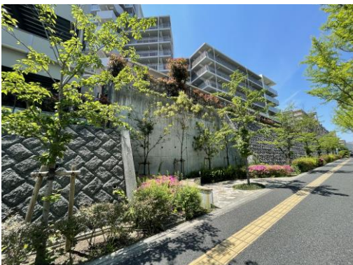
セットバックした石積み擁壁の前面に植栽を施した例
