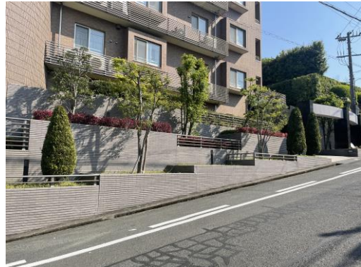
擁壁の意匠を工夫し、緑化を施すことで圧迫感を低減している例
