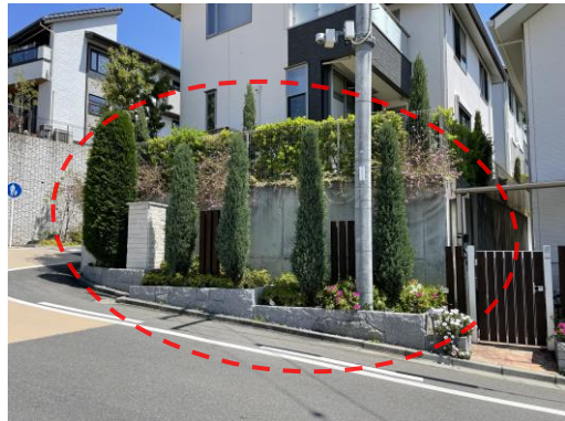
擁壁の位置を少し道路から後退させて植栽を設けている例
