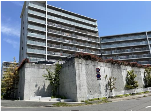
擁壁を一部セットバックさせ、縦目地の化粧型枠を用い、圧迫感を低減している例
