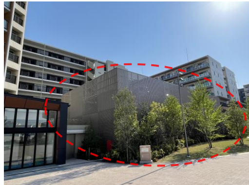
機械式駐車場を建物と調和する色彩のルーバーで隠している例
