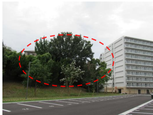
斜面に保全された樹木の例
