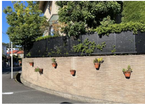
塀にハンギングポットを設置し、敷地内の緑化に努めている例
