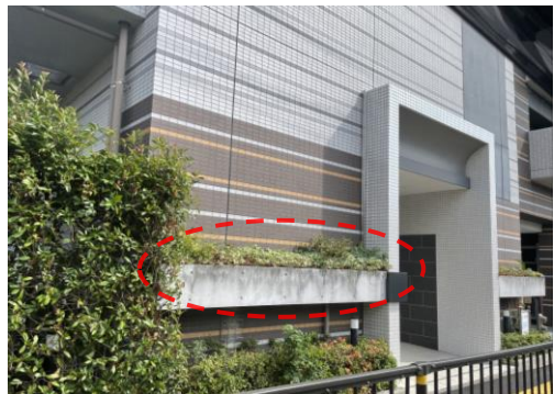
外壁と一体となったフラワーポットを設置し植栽を工夫している例
