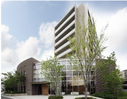
共同住宅のエントランスを印象づけるシンボルツリーの例
