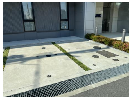
土間コンクリートの目地に玉石や地被植物を植えることで、表情のある仕上げとしている例
