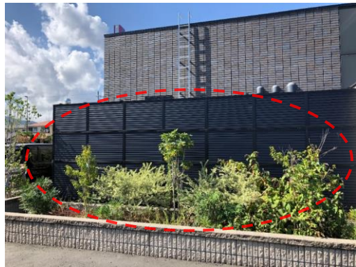
付帯設備を黒色のルーバーと植栽で目隠している例
