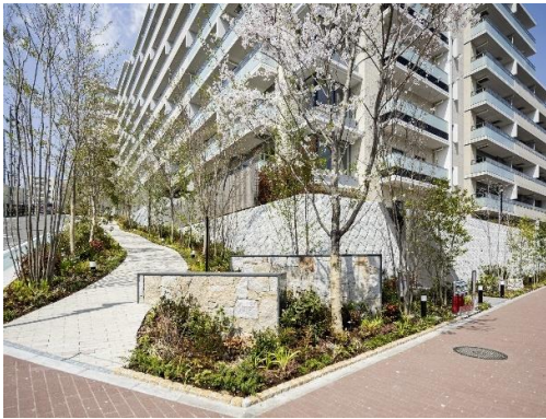
敷際のオープンスペースに、四季を感じさせる植栽を施している例
