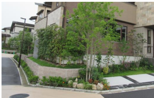
敷際の擁壁をセットバックさせ、わずかな隙間に植栽を施し積極的に緑化している例
