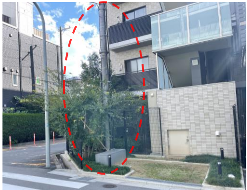
敷際に設置する引き込み柱の周りを緑化し、目立たなくしている例
