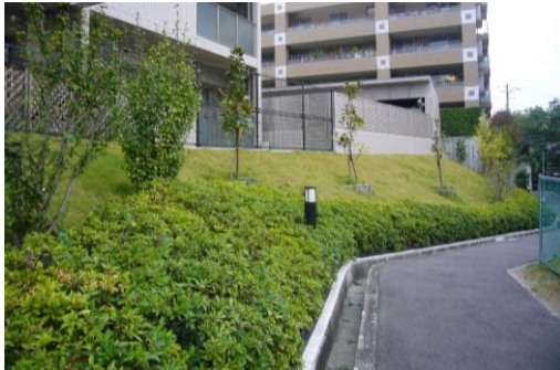
擁壁ではなく法面にし、芝や高木・低木で多様な斜面緑化をしている例
