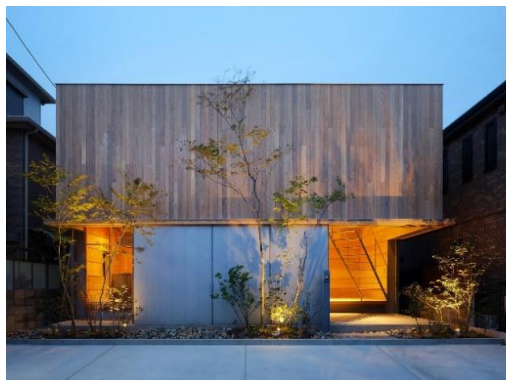
屋内からの光と、外構の樹木に当てる光の、二つの間接照明で陰影をつくっている例
