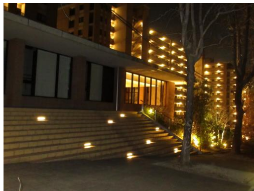
足元灯により、眩しくならないように配慮しながら、歩行空間の安全性を確保している例
