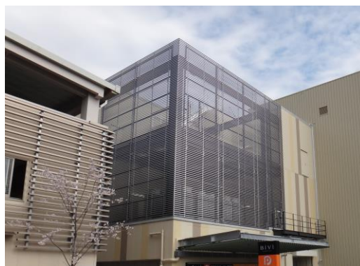
ルーバー等を用いて建物と一体的にデザインしている例
