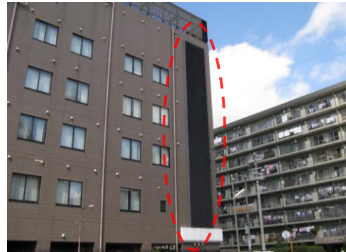
ルーバーで壁面設備を隠している例
