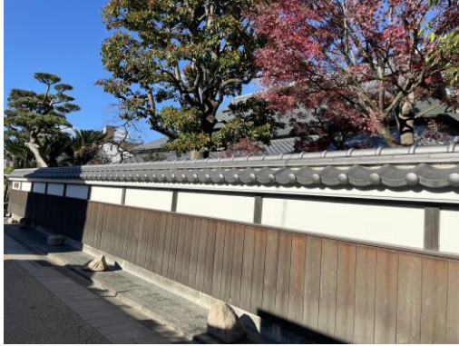
漆喰や板壁など昔ながらの風景が残る敷際の例
