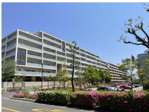
隣り合う建物で壁面の形態をそろえられ、まちなみが整っている例
