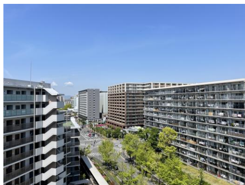
建物の壁面位置を周囲のまちなみと合わせ、周辺の景観と調和させている例
