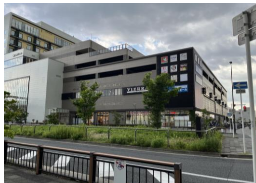
階数に変化を持たせて長大な壁面とならないよう工夫している例
