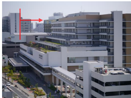
中高層部の壁面を後退させ、ボリューム感を低減した例
