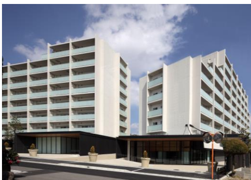
分棟により圧迫感を低減している例
