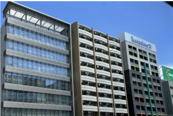
壁面ラインやスカイラインを整えて、通りとしてまとまりのある景観をつくり出しましょう
