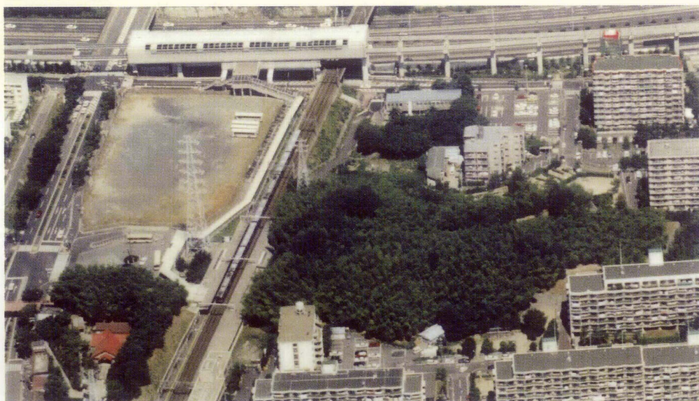
施工前の写真
