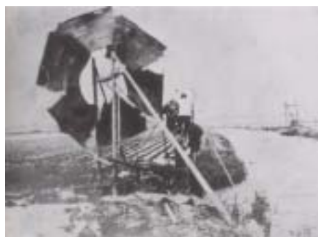
昭和 10 年 大井路の揚水車 (南吹田五丁目付近)
