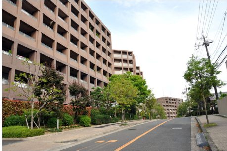
分譲マンションが集積するまちなみ (古江台3丁目)
