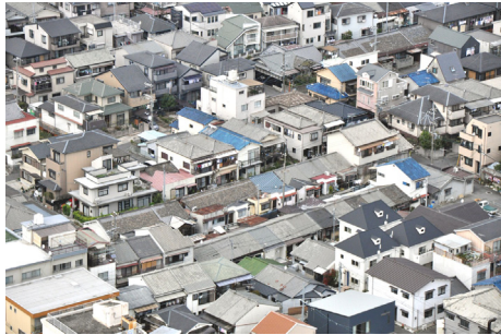
戸建木造住宅が密集する住宅地 （片山町3・4丁目）
