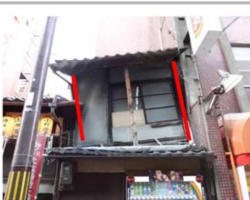
2階部分が沈み込み全体的に傾斜している
