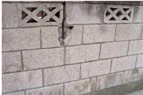
塀に大きなひび割れが生じている
