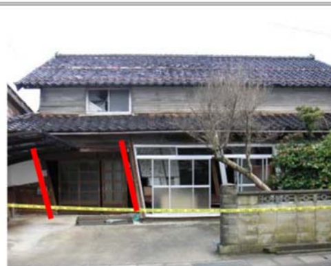
1階部分が傾斜している
