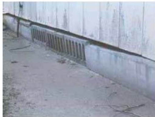
基礎が沈下し破損している
