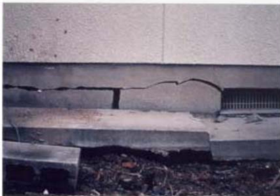
基礎が大きく破損している
