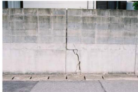
塀に大きなひび割れが生じている
