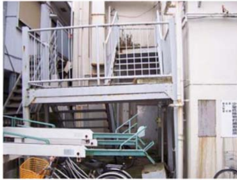
屋外階段が傾斜している
