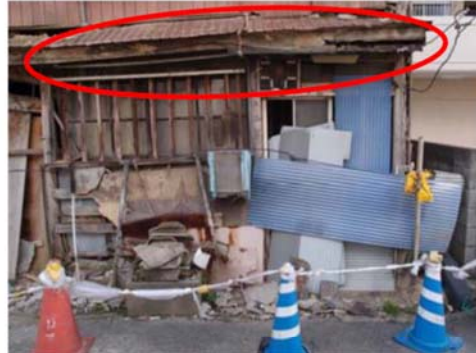
軒に不陸、剥離が生じている
