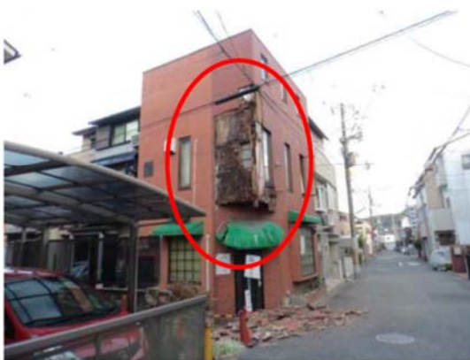
外壁が破損している
