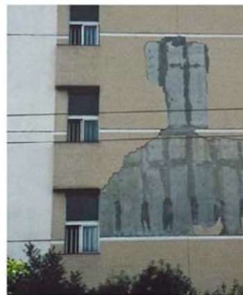
外壁に脱落が生じている
