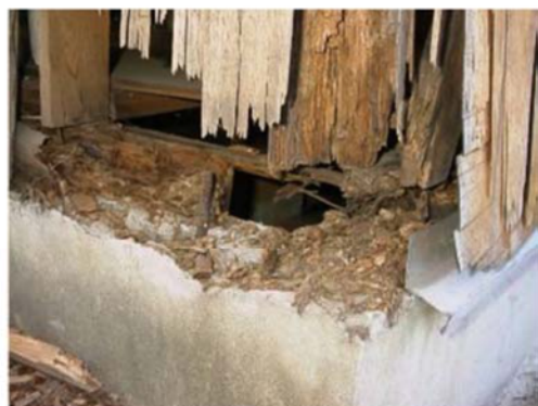
蟻害が発生し欠損している
