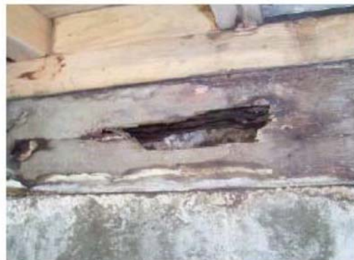
土台に蟻害が発生している
