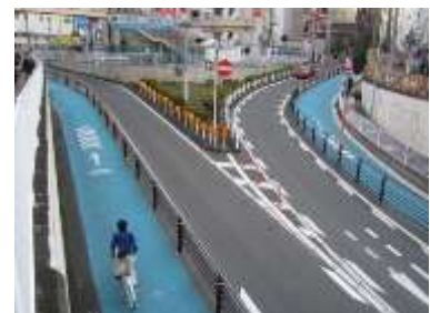
写真 5-1 整備例（川崎市）
