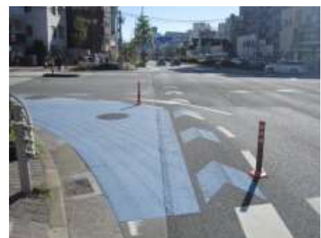
写真 5-13 左折巻き込み防止の例(東京都文京区)
