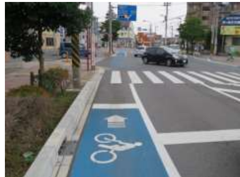
写真 5-9 停止線前出しの例(茅ヶ崎市)
