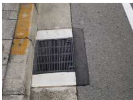
写真 5-6 グレーチング蓋の格子間隔を狭め、滑り止め加工している例（大阪市）
