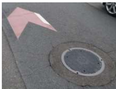
写真 5-7 マンホールの蓋に滑り止め加工をしている例（京都市）
