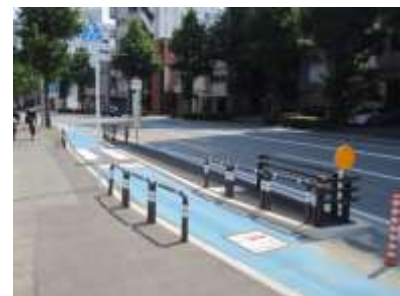
写真 5-18 交通島を設置している例（福岡）
