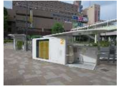
写真 3-10 機械式地下自転車駐車場 (阪急南千里駅)
