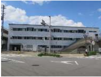
写真 3-8 階層式自転車駐車場 (JR吹田駅)
